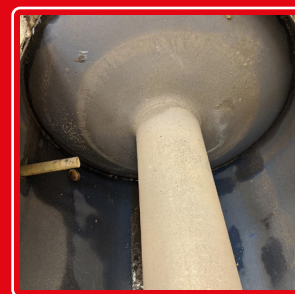
بعد از نصب
