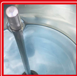
بعد از نصب
